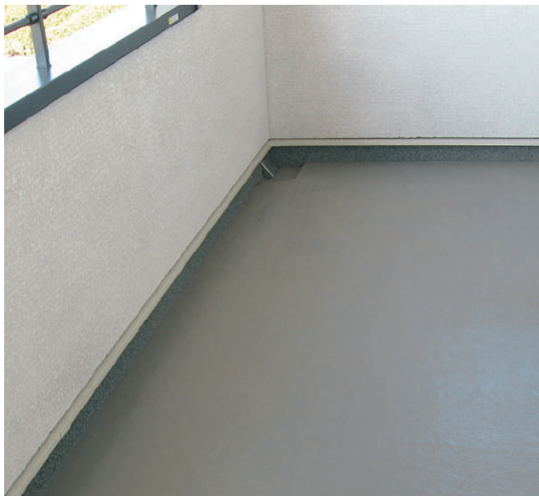
●仕様例 複合FRP防水[断熱工法]
