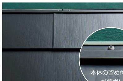
施工イメージ(UP)
